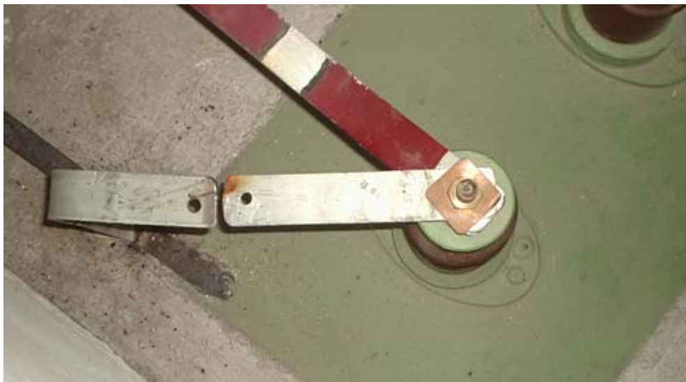
Фиг. 1.3.1. Конструкция на оригинално искрище в подстанция “Провадия”
